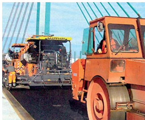
Pokládka asfaltové vrstvy na mostě
