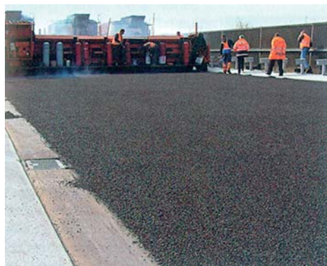
Zpracování litého asfaltu
