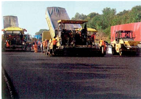
Pokládka směsi typu PA
